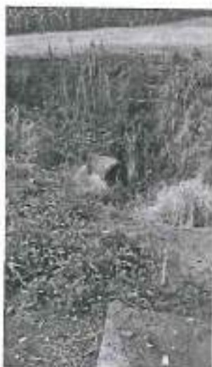
Foto 3.26 – Final da rede de drenagem na erosão
