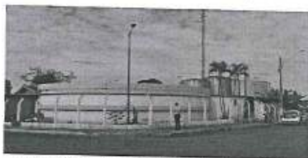
Foto 3.10 – Reservatórios do Cemitério
