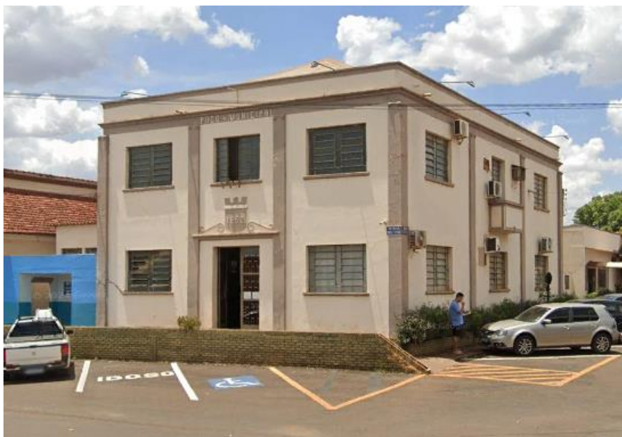
Foto 1. Local da Obra.
